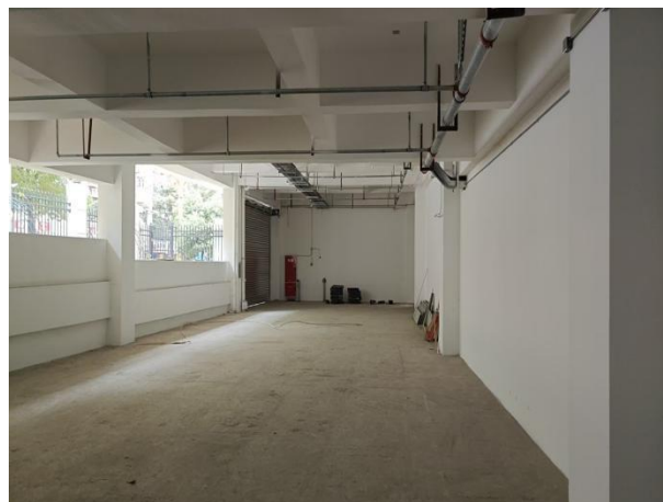
拟建加速器机房上方
