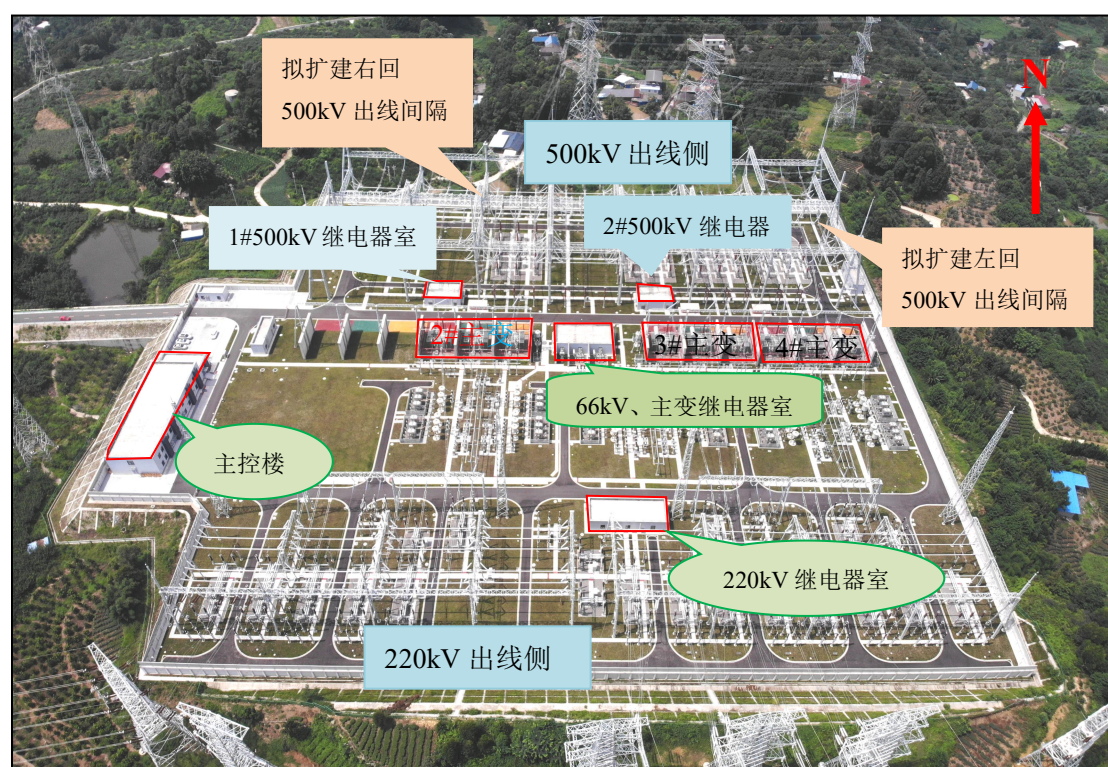
图 3-1 乐山南 500kV 变电站现状
