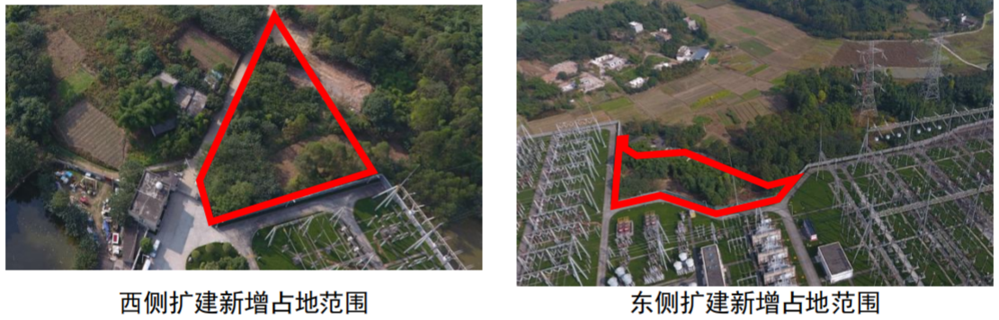
图 3-4 尖山 500kV 变电站本次新增占地范围及现状照片
