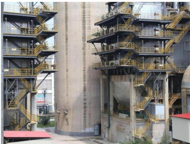
▲ 1#、2#窑高温高尘 SCR 烟气脱硝系统
